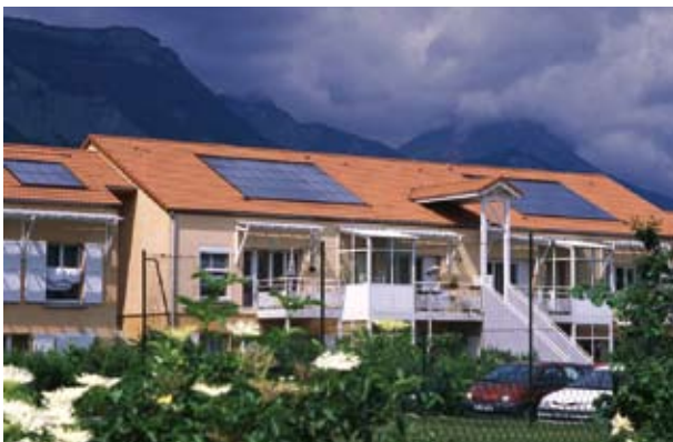
Un petit ensemble d'habitat collectif social doté d'équipements solaires, en région Rhône-Alpes.
