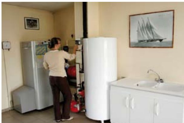
L'encombrement du ballon d'un chauffe-eau solaire individuel est comparable à celui de tout autre type de ballon.
