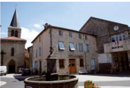
À Saint-Germain l'Herm (Puy-de-Dôme), le réseau de chaleur communal alimente des logements sociaux et des bâtiments publics et privés.
