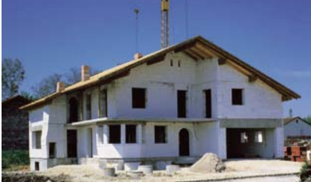
Construction en béton cellulaire
