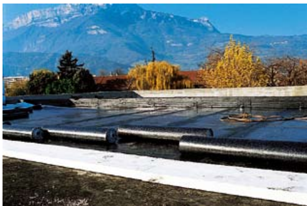
L'isolation d'une toiture-terrasse
