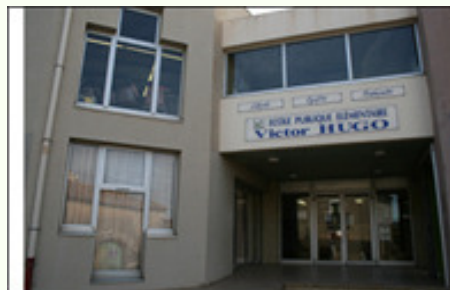
Entrée principale (façade Ouest)
