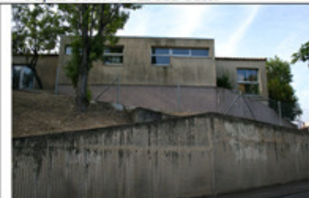
Autre partie de la façade Nord
